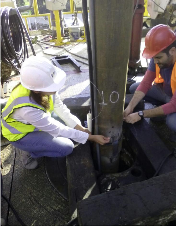
Figura 66. Instalación del sensor en la tubería de la bomba previa las pruebas de aforo.
